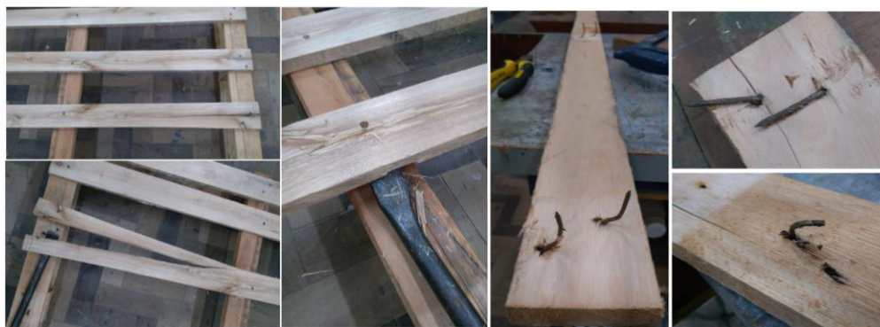
Figura 01 - Sarrafos quebrados e rachados (esquerda); pregos dobrados (direita)
